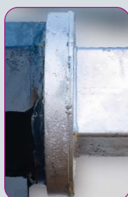
Base giro de la torre
